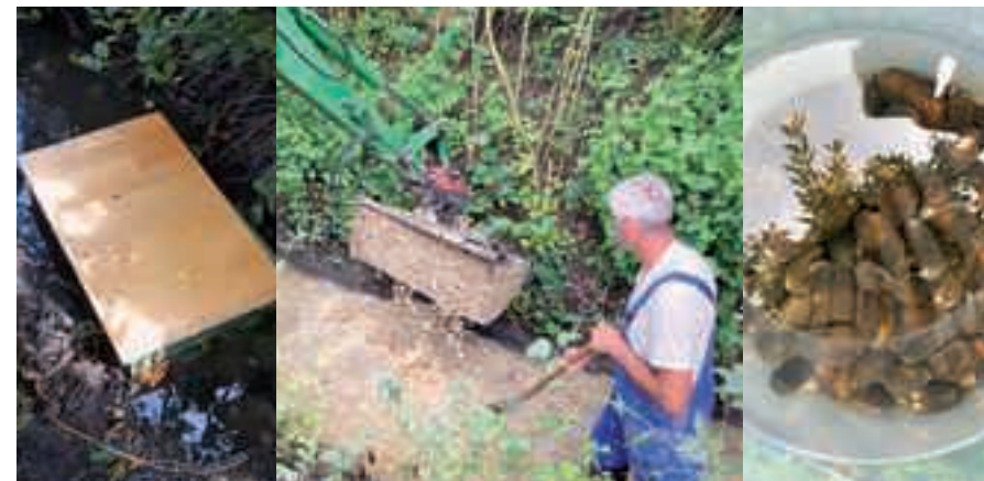
ZWISCHENLAGERUNG DER MUSCHELN IM OBERLAUF DES BACHES, HERSTELLUNG DER NEUEN BACHSOHLE MIT VERSCHIEDENEN SCHICHTEN AUS LEHM, SAND, FEINEREM UND GRÖßEREM KIES.
