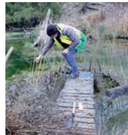
ANGESCHWEMMTES MATERIAL UND DER BIBER HABEN IMMER WIEDER DEN MÖNCH (DAS ABFLUSSBAUWERK) VERSTOPFT UND DADURCH DAS NACHBARGRUNDSTÜCK MIT ÜBERFLUTET.
