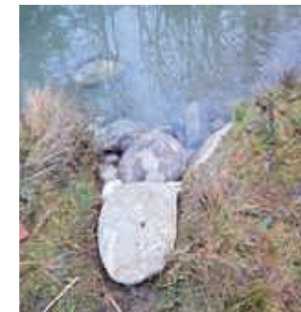
ANGESCHWEMMTES MATERIAL UND DER BIBER HABEN IMMER WIEDER DEN MÖNCH (DAS ABFLUSSBAUWERK) VERSTOPFT UND DADURCH DAS NACHBARGRUNDSTÜCK MIT ÜBERFLUTET.
